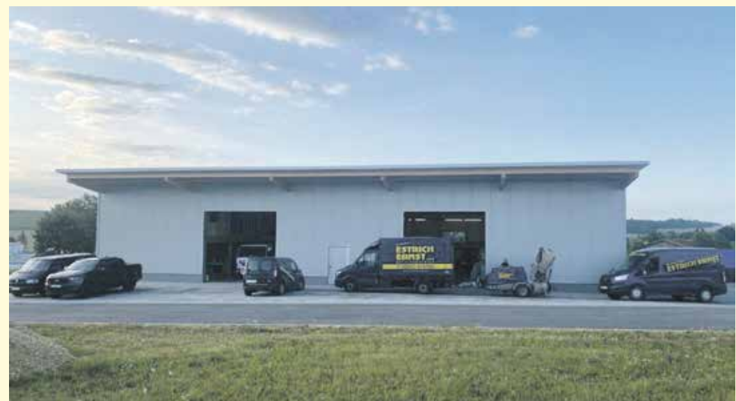
Die neue Halle in der Raiffeisenstraße 5 bietet nun ausreichend Platz für Materialien, Aufenthaltsmöglichkeiten für Mitarbeiter und Büroräume. Fotos: Ernst
