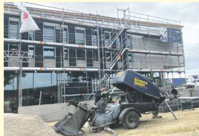
Ob Großbaustelle, Neubau oder kleine Sanierungsmaßnahmen in Privathaushalten – Estrich Ernst ist stets ein zuverlässiger und kompetenter Partner.
