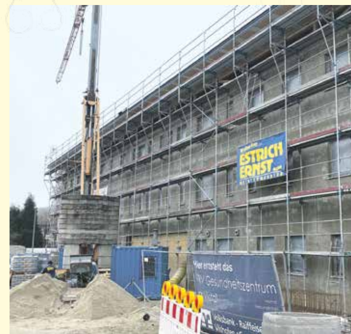
Selbst Großbaustellen wie bei Betriebs-, Industrie- oder Hotelneubauten sind Dämmung und Estrich für den Ortenburger Familienbetrieb kein Problem.
